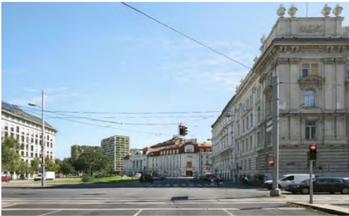
Summer View (© Murr Architekten)
