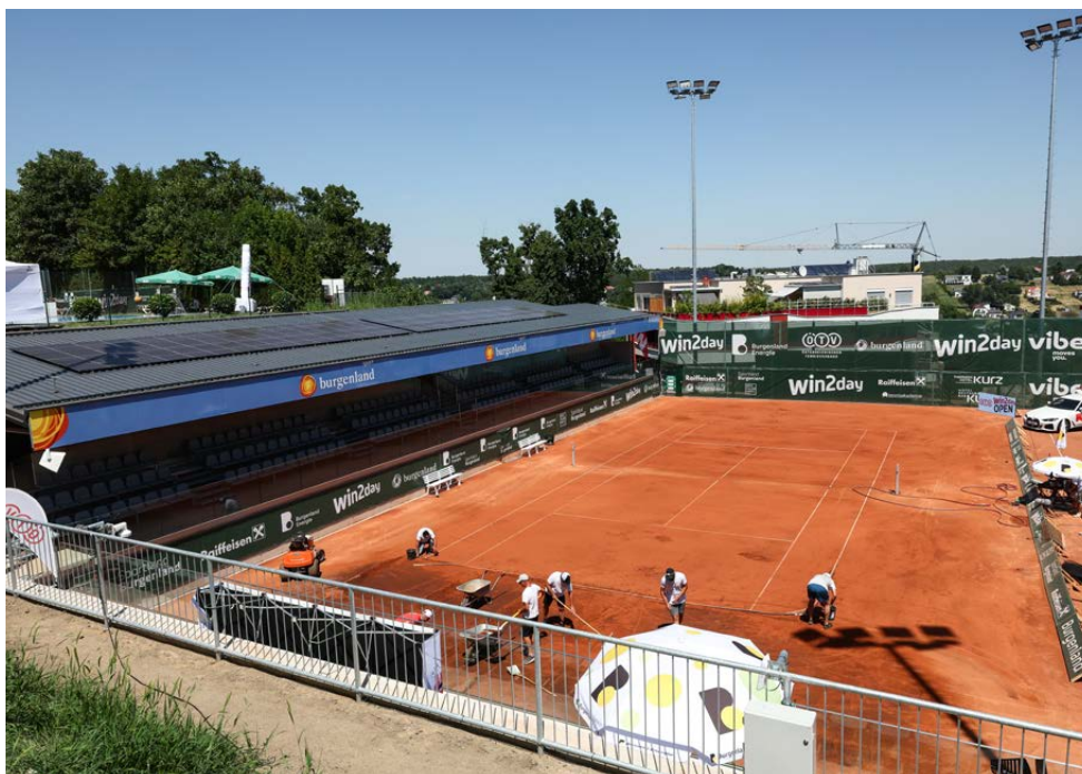
Renovierungsarbeiten beim Center Court in Oberpullendorf.
