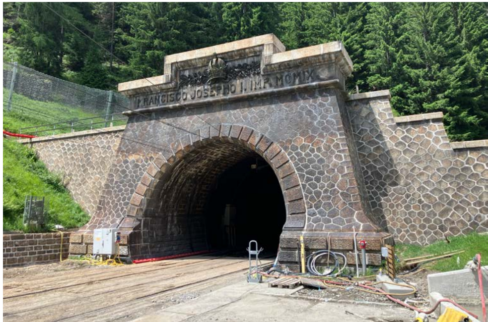
Südportal des Tauerntunnels, Mallnitz
